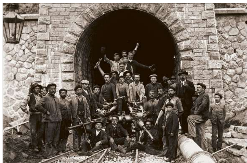
Erecziun dal tunnel da viafier da l'Alvra ch'è vegnì avert il 1903.
